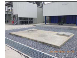
บ่อแยกน้ำ-น้ำมัน (Oil Separator)
